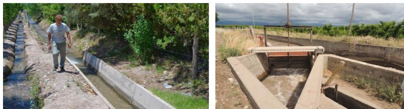
Figura 7. Canales de riego impermeabilizados con hormigón (derecha) y sin impermeabilizar (izquierda). Fuente: Departamento General de Irrigación (1) y elaboración propia (2).
